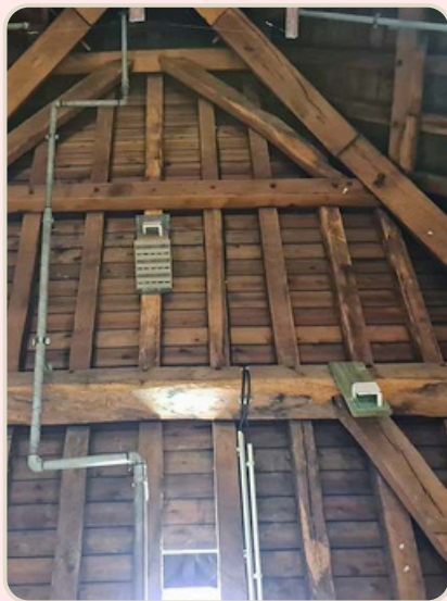
Beamdetectoren in Sint-Romboutskathedraal, Mechelen © Provincie Antwerpen
