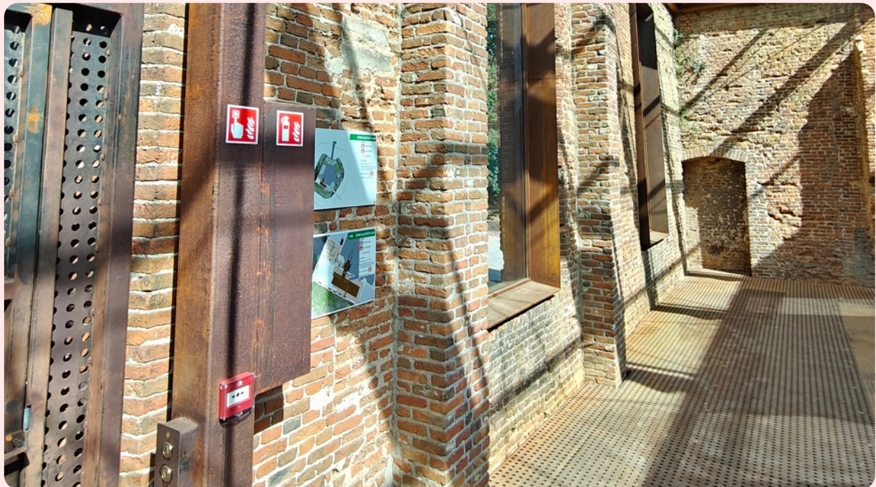
Handbrandmelders in kasteelruïne Ter Elst, Duffel © Stichting Kempens Landschap
